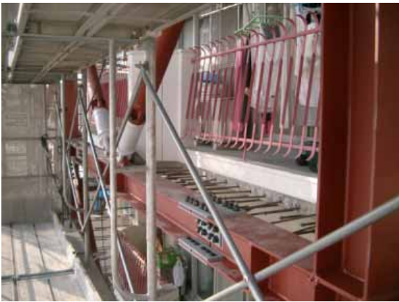
写真 - 4 鉄骨、制震ブレース建方
