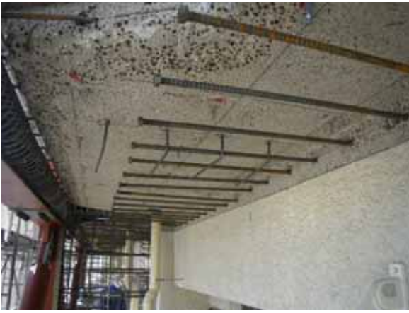
写真 - 3 バルコニー slab 下、目荒し、アンカー打設
