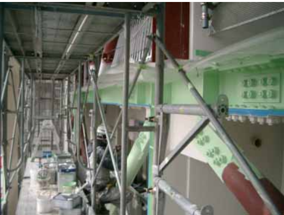
写真 - 5 鉄骨、制震ブレース塗装
