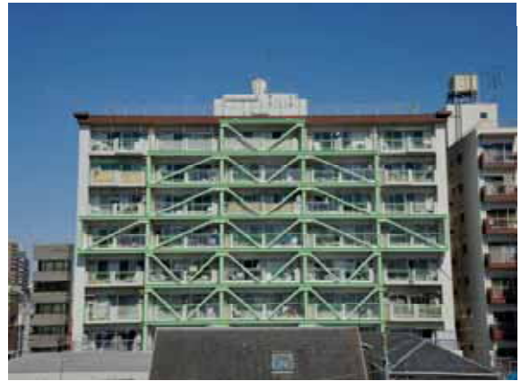
写真 1 バルコニー面の補強
